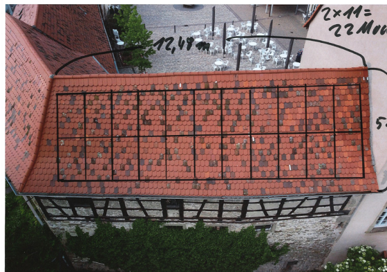
Südosten mit 22 Modulen
